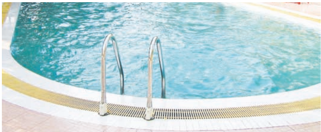
El metal cromado resiste mejor el deterioro ocasionado por el cloro.
